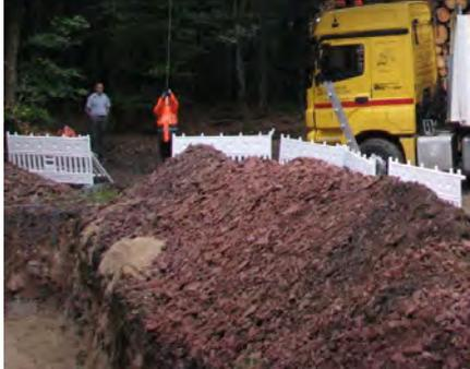
Der Tank wird in die vorbereitete Grube abgelegt und mit Erde abgedeckt
